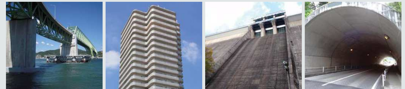
橋梁、擁壁、堰堤、トンネル、コンクリート舗装、ビル、その他コンクリート建造物全般
